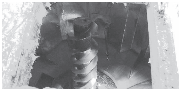
停止中のパルパー内部
