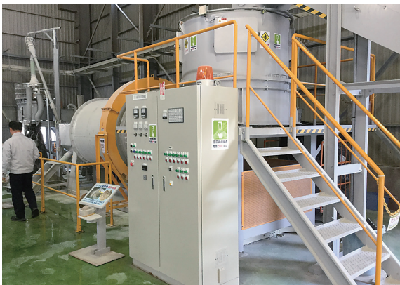
(株)トリム様 工場内部
